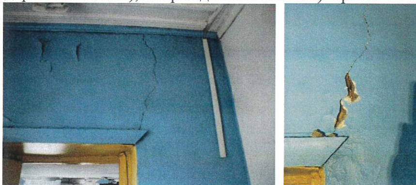
трещины в кирпичной кладке стен
