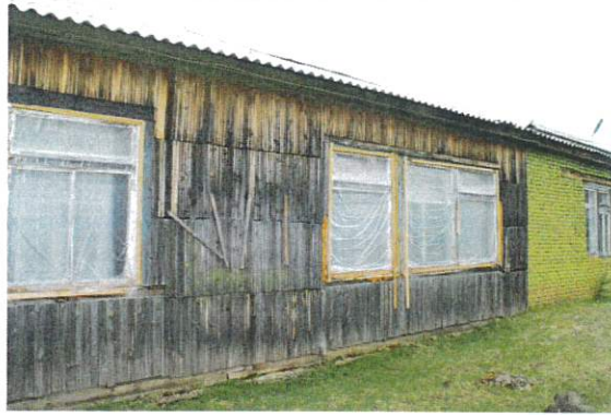
общие деформации стены по оси Р/13-17
